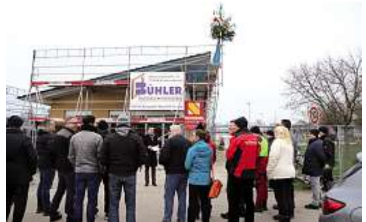
Richtfest des neuen Mehrzweckgebäudes
