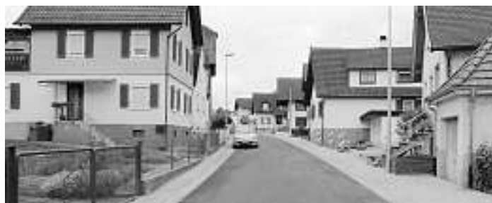
Fertigstellung der Baumaßnahme in der Friedenstraße
