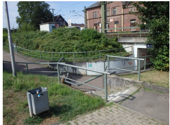
Abb. 4-39: Zugang zur Unterführung
