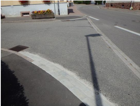
Abb. 4-34: Gehwegabsenkungen in Schuttern
