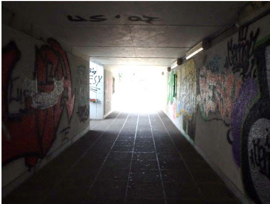
Abb. 4-25: Unterführung am Bahnhof
