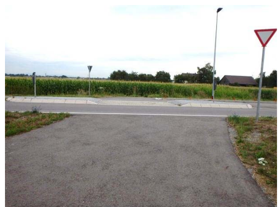
Abb. 4-22: Mittelinsel am Ortseingang Friesenheim Süd
