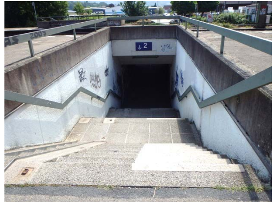
Abb. 4-26: Rampe zur Unterführung
