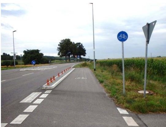
Abb. 4-21: Querungshilfe am Ortseingang in Friesenheim Süd
